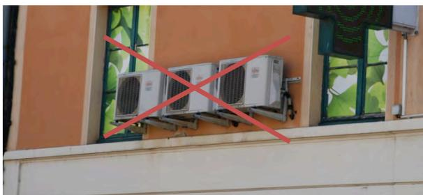
*Les antennes, les éoliennes domestiques, les appareils aérauliques doivent être positionnés de façon à être invisibles depuis l'espace public*
