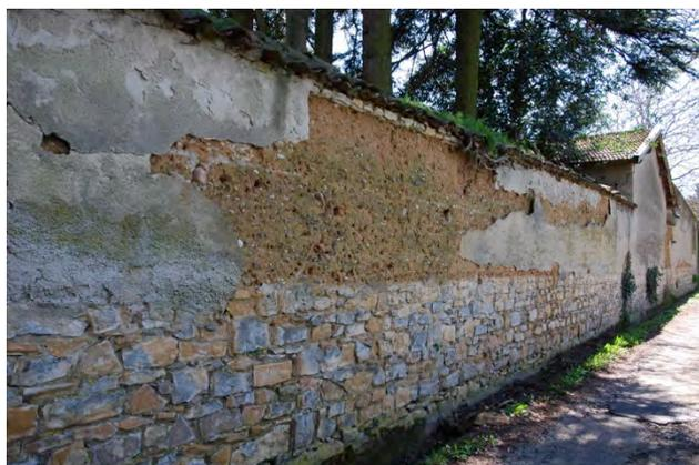
Mur de clôture avec base en pierre et partie supérieure en pisé
