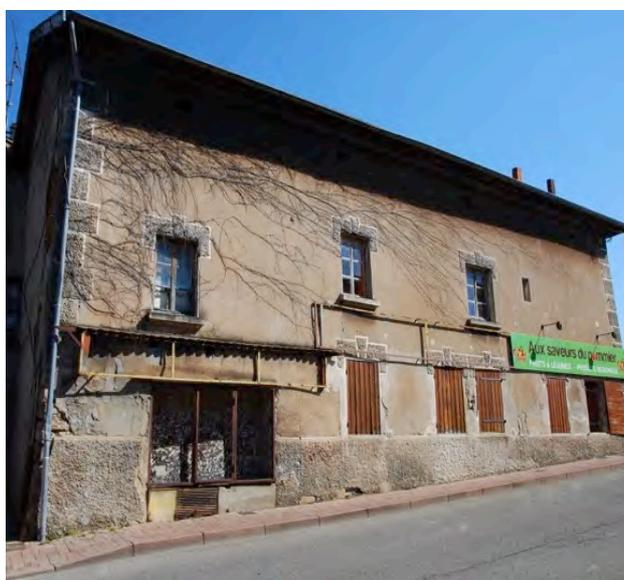
*Bâti traditionnel dans le bourg avec grande inertie des matériaux et des ouvertures de taille réduite*
