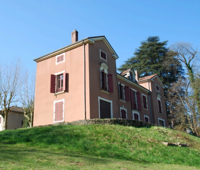
Maison Levrat au bord de l'étang de Fallavier
