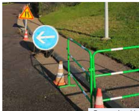
Travaux de voirie
