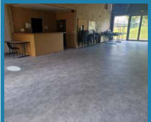
✓ NYMPHÉA Remplacement du sol de la grande salle. Coût des travaux 7 400€
